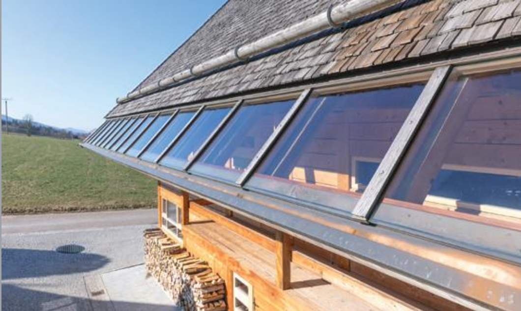
Belichtung für den Wohnteil mit teilweise verglaster Traufe
