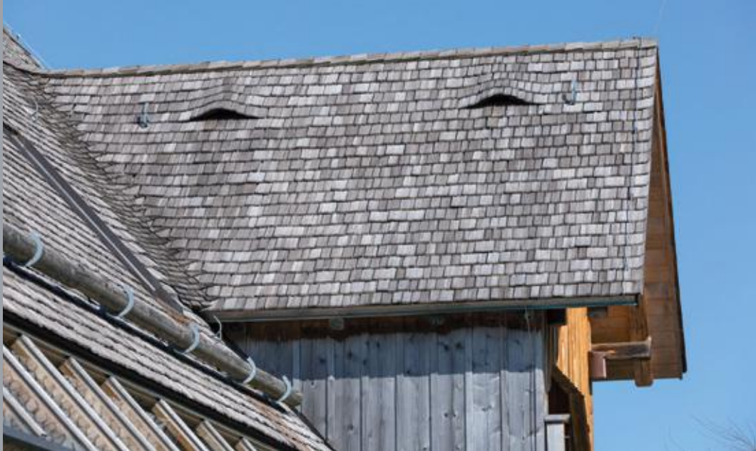
Ausgewogenes, am Bestand orientiertes Erscheinungsbild: Reduzierte Belichtung, kleine Lüftungsgauben und neue Schindeleindeckung
