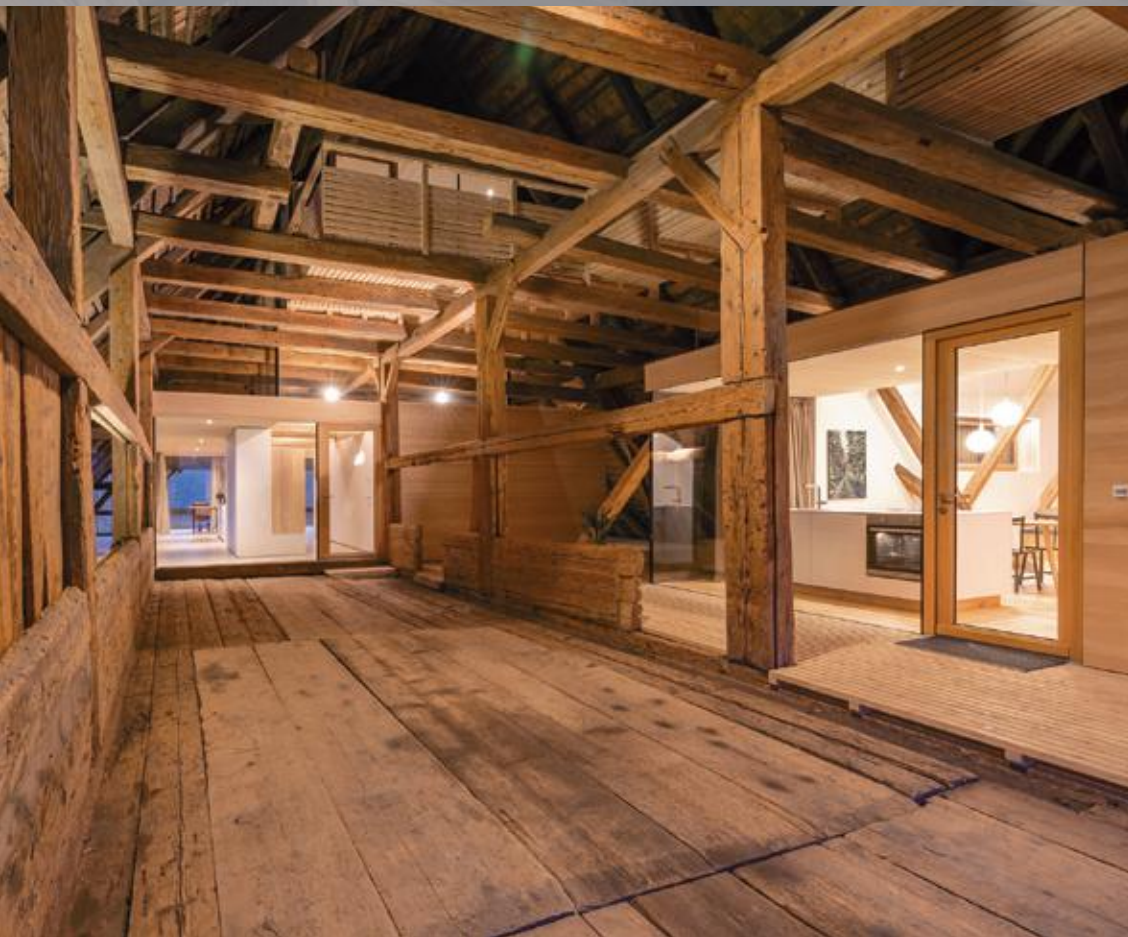
„Haus-in-Haus-Lösung“ im Ökonomieteil (siehe Titelbild)
