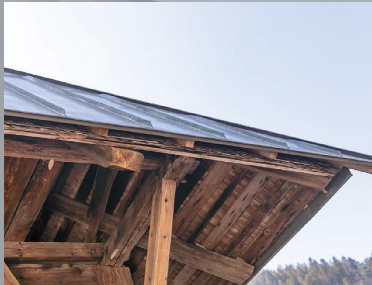
Moderne Blecheindeckung des Walms, darunter das historische Schindeldach
