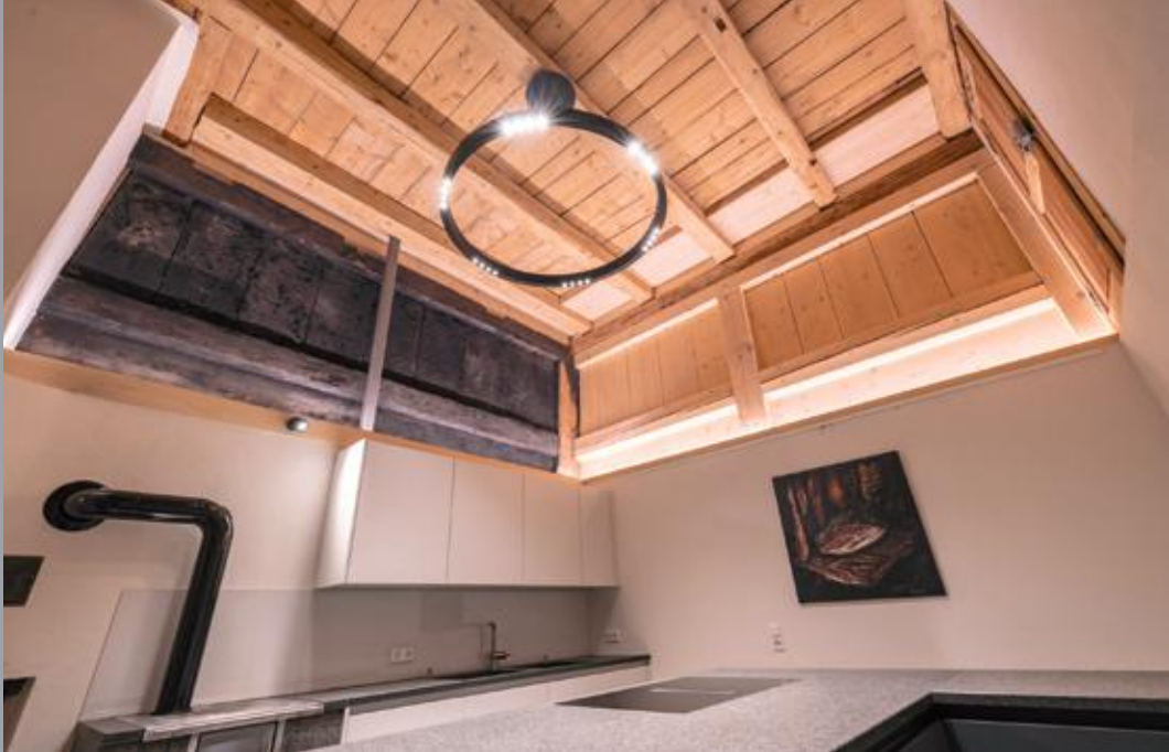
Ehemalige Rauchküche mit Spuren der rußgeschwärzten Bohllendecke und modern interpretiertem Rauchgewölbe (helles Holz)
