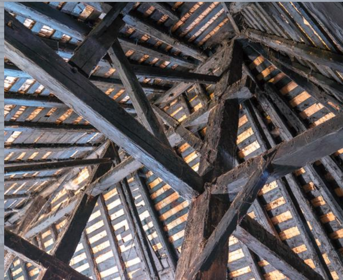
Originaler und rauchgeschwärzter Dachstuhl ohne Umnutzung in Menzenschwand
