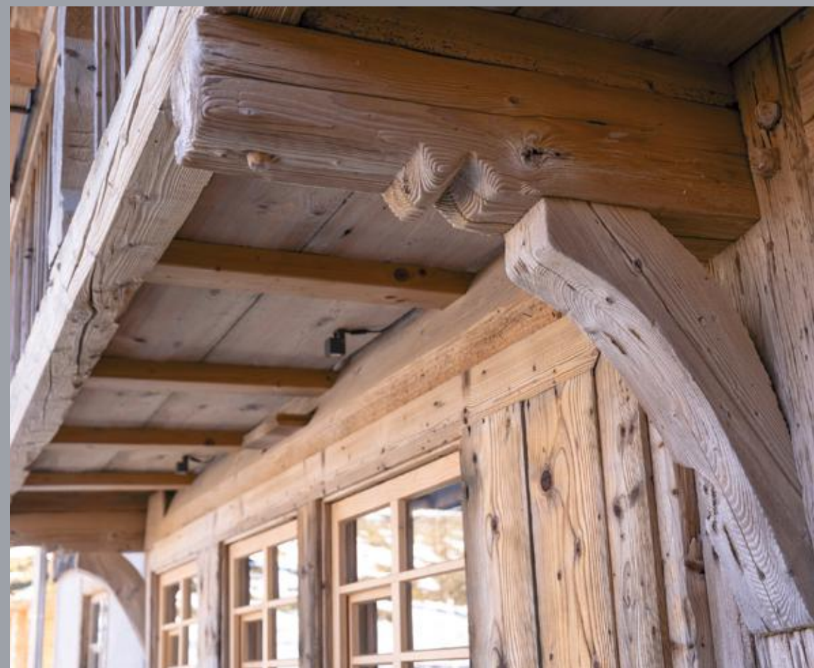
Charakteristische Fensterzone und hölzerner Balkon (Trippel) am Altbirklehof Hinterarten
