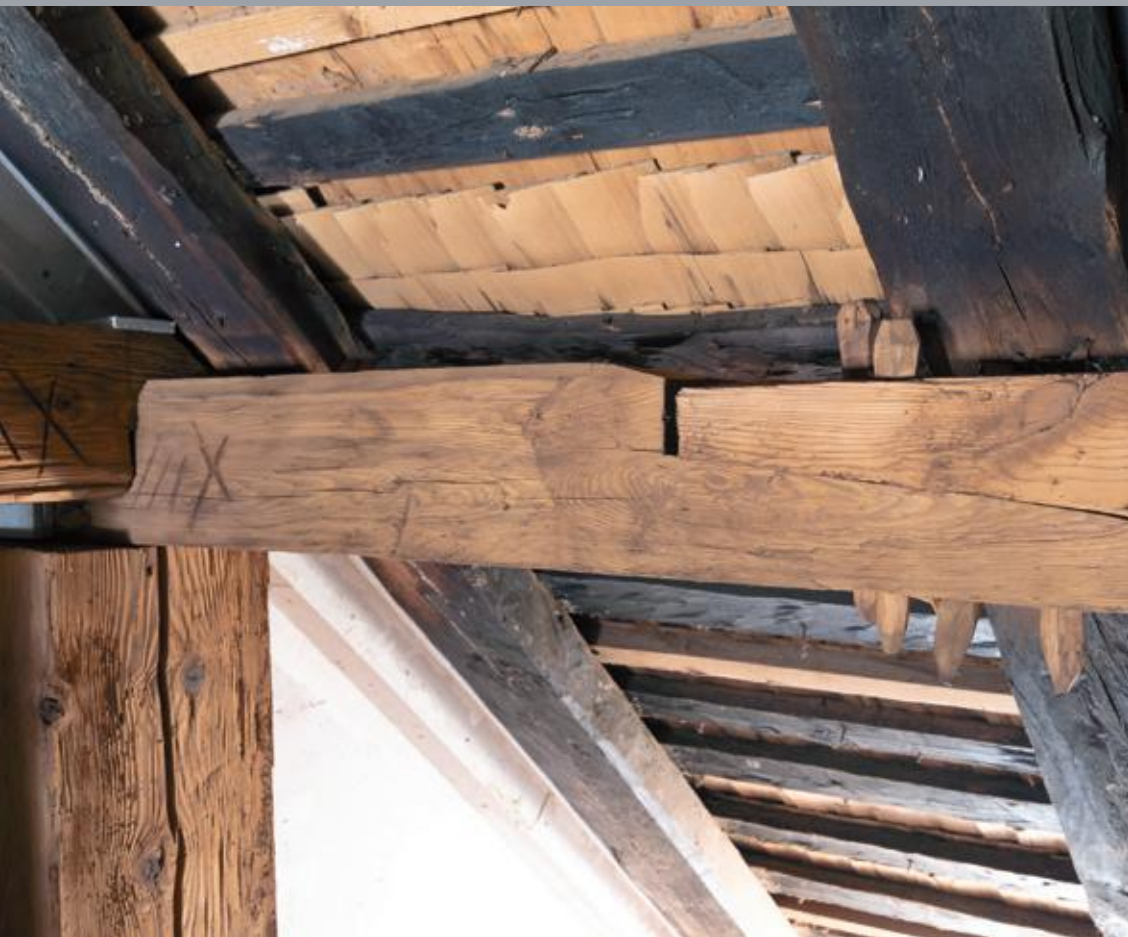
Charakteristisches Detail einer originalen Dachstuhlkonstruktion mit Holznägeln und Abbundzeichen
