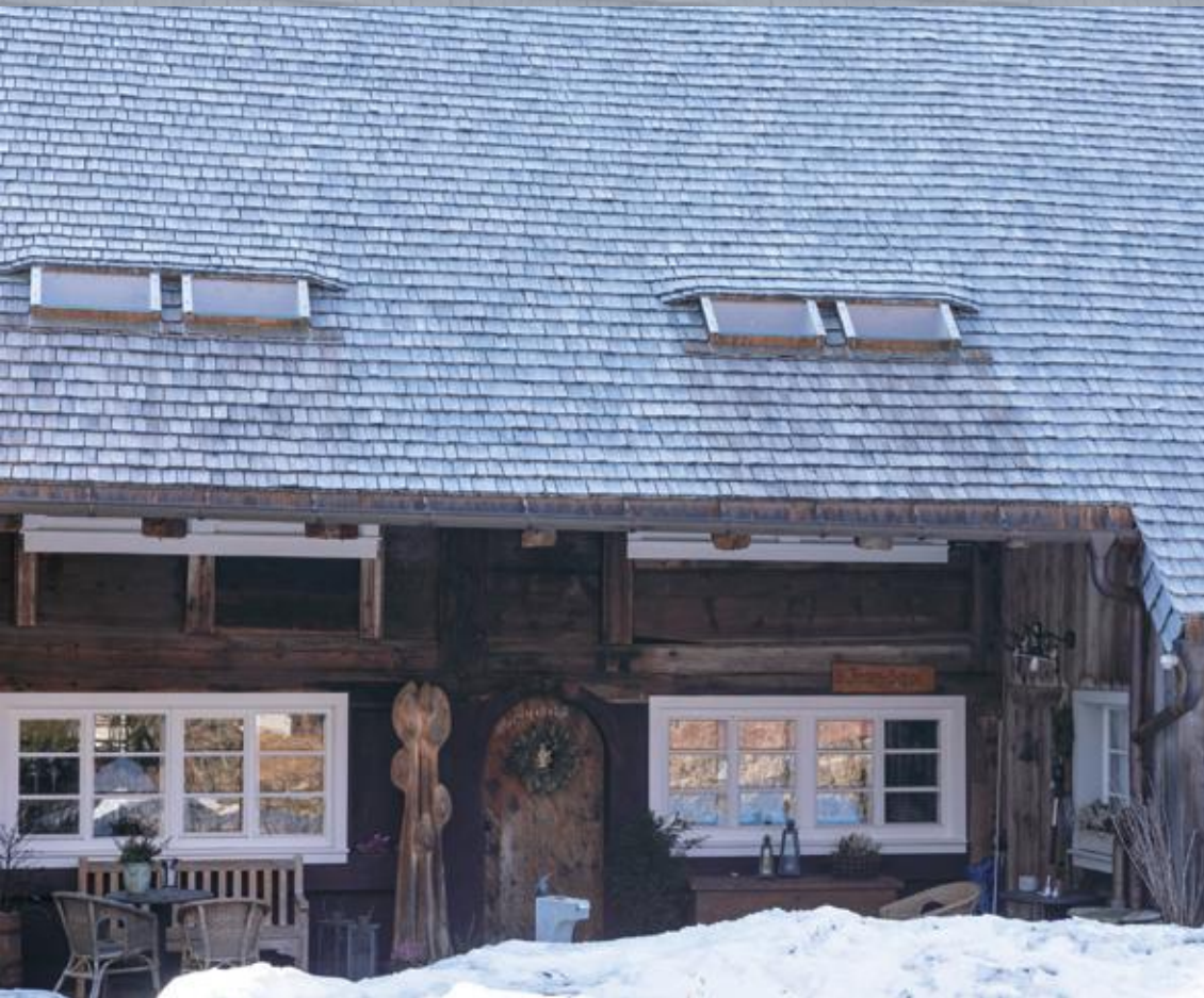
Eingebettet in das Schindeldach, ermöglichen moderne Dachfenster zusätzlichen Lichteinfall für die Wohnräume
